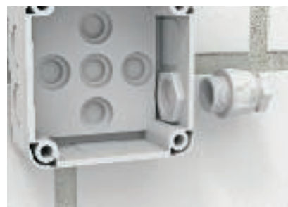
Кабельный ввод Вместо вставного уплотнения можно также использовать кабельные вводы. Кабельный ввод закрепляется контргайкой.
