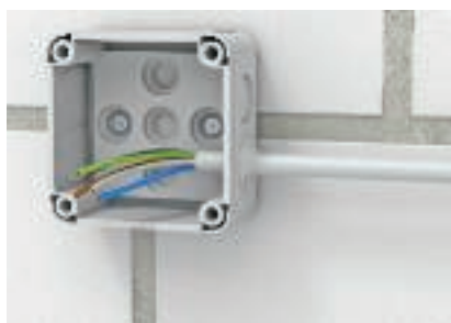
Кабельные вводы с вставным уплотнением Вставное уплотнение открывается в соответствии с диаметром провода. В заключение провод вводится в распределительную коробку.
